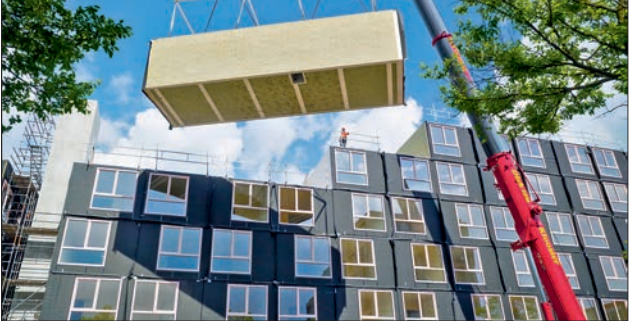
Oben: Die Module bestehen weitgehend aus CLT-Elementen, woraus ein hoher Holzanteil resultiert. Unten: Das aus baugleichen Modulen errichtete Mehrparteienhaus.
