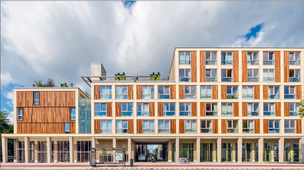
Der Abtrag der Vertikallasten der exakt übereinander gestapelten Module erfolgt von oben nach unten über die äußeren Modulwände. Fotos: Derix-Gruppe
