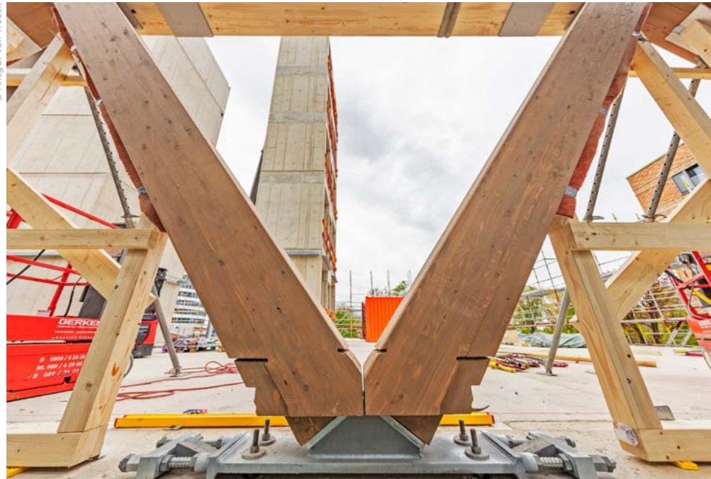
ZIRKULÄRES BAUEN: leimfreie Steckverbindung ↑
