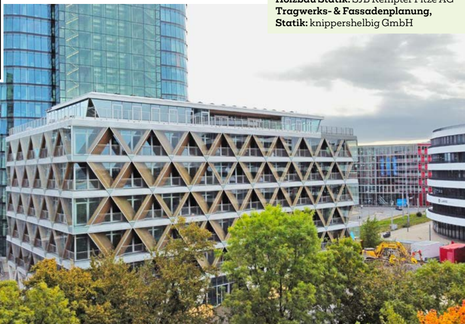
ZIRKULÄRES BAUEN: Einheben vormontiertes Fassadenelement ↑
