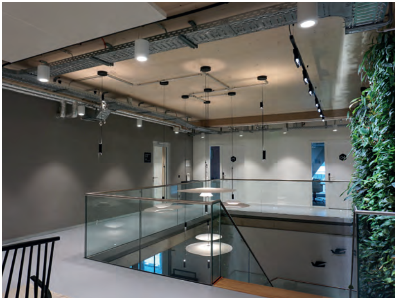
De CLT vloeren maken forse overspanningen van 6 tot 7,15 meter. Groenwanden zorgen voor luchtzuivering en akoestiek.
