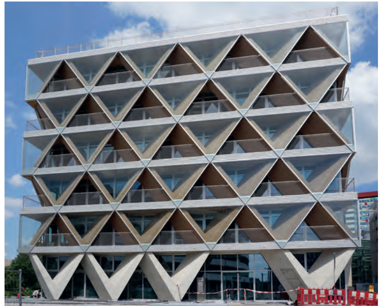
Entreegevel op het zuiden.
