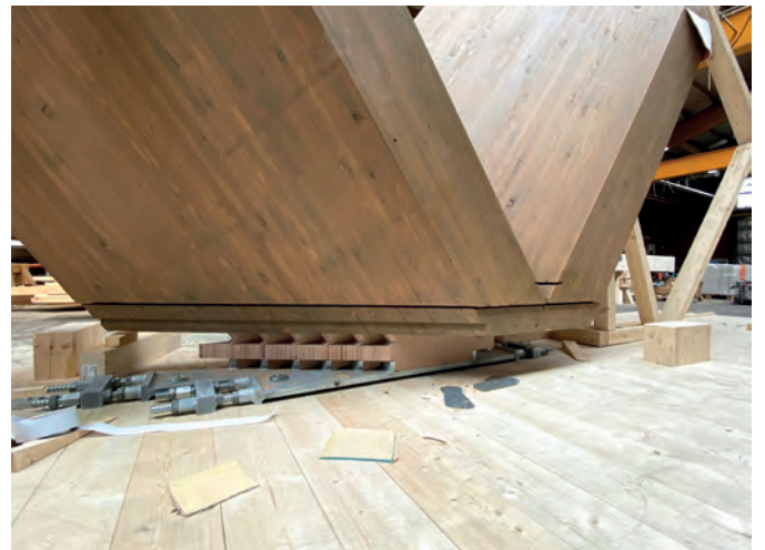
Door zijn gewicht zet de kolom zich vast, zonder lijm of schroeven.
