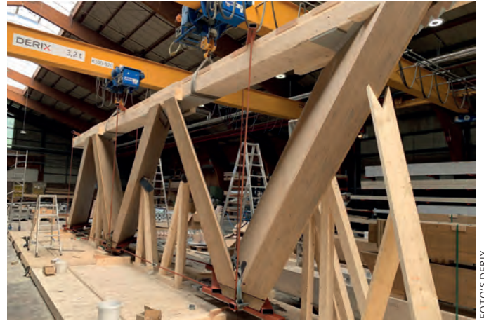
Proefopstelling van de V-vormige gevelelementen vastgeklemd in CNC gefreesde verbindingstukken uit Baubuche.
