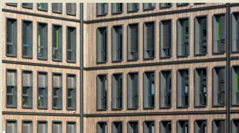
Durch die Konstruktion als Stecksystem nach dem Baukastenprinzip kann das Gebäude in Zukunft problemlos zurückgebaut, erweitert oder verkleinert werden. Die Bauelemente sind dabei nach Material sortenrein zu trennen und wieder dem technischen Kreislauf zuzuführen. Der ausführende Holzbaubetrieb gibt eine Rücknahmegarantie für alle von ihm verbauten Hölzer.
