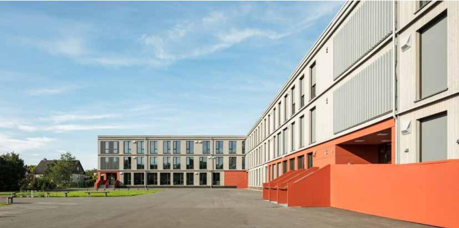
Die 60 m<sup>2</sup> großen Klassenräume bestehen aus drei 20 m<sup>2</sup> Modulen: einem mit Schrankzone (inkl. Lüftungstechnik), einem mit Anschlüssen für digitale Tafeln und Tür sowie einem Mittelmodul (bzw. mehreren Mittelmodulen bei größeren Räumen).
