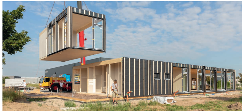
Holzmodul bei der Montage Büro Leister, Willich
