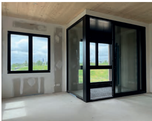
In plaats van balkons is gekozen voor loggia's. De uitvoering verschilt naar gelang van de geluidbelasting van de gevels.
