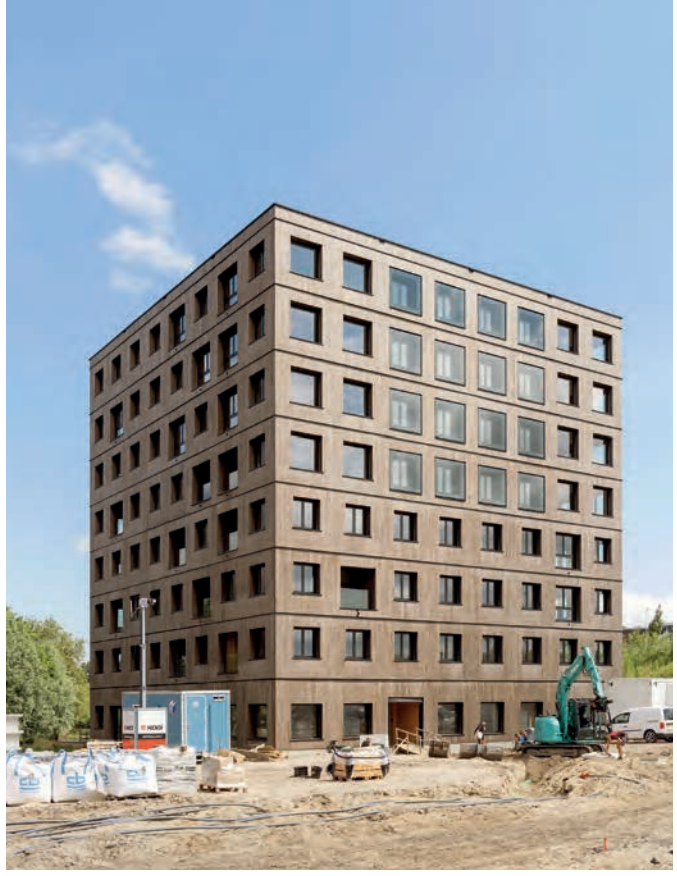
De toren ligt vlak bij drukke wegen. Vooral op de hogere verdiepingen zijn bij gevelopeningen daarom geluidwerende maatregelen genomen.
