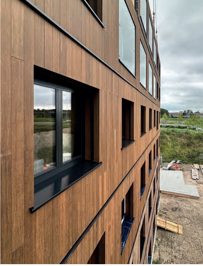
De toren ligt vlak bij drukke wegen. Vooral op de hogere verdiepingen zijn bij gevelopeningen daarom geluidwerende maatregelen genomen.
