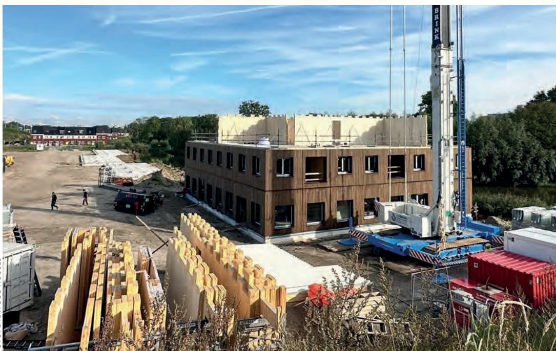
Naast de CLT kern zijn er per bouwlaag enkele doorlopende CLT wanden aangebracht voor de constructieve stabiliteit.
