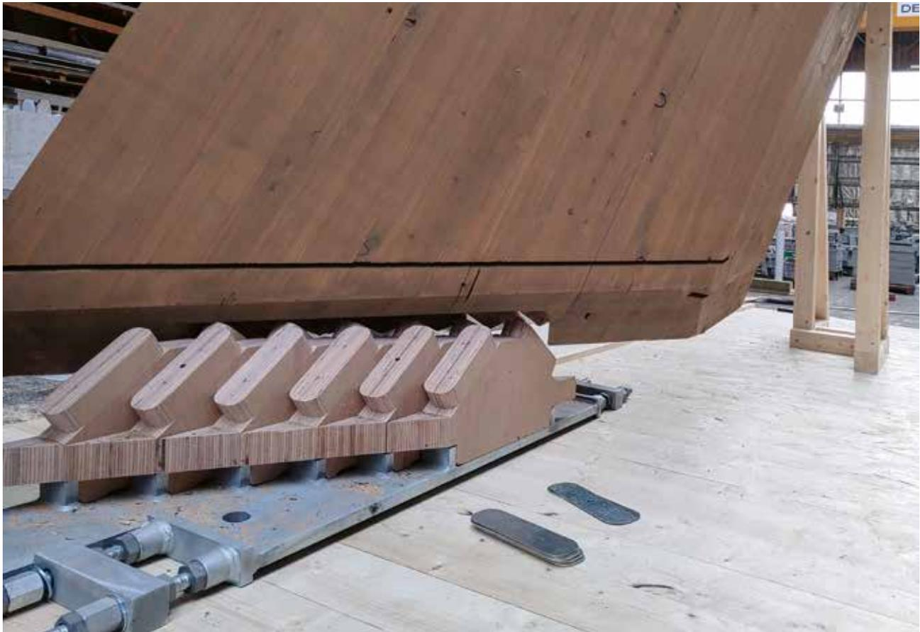
**Ein Element des Tragwerks wird auf den Stützenanschluss vormontiert.** Es hält ohne Leim und Schrauben in erster Linie durch seine Schwerkraft.
