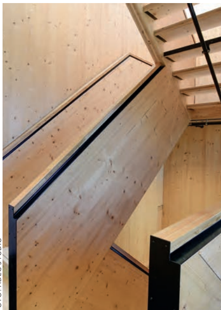
De zwarte opdekplaat verbergt de stalen strip die de borstweringen aan elkaar vastzet. De plaat sluit optisch mooi aan op de subtiele leuning.
