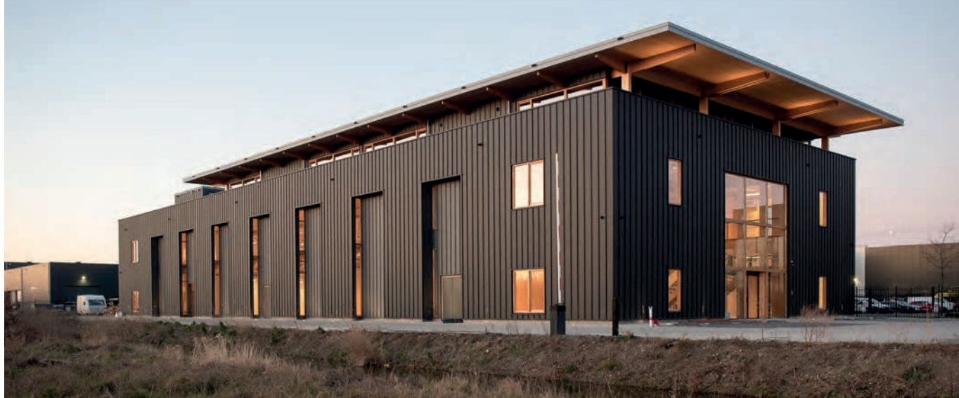
Op de kopgevel is het dakoverstek maar liefst 4 meter.
