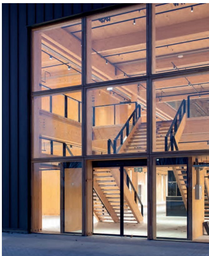
Nick Krouwel maakte een precieze maquette. In de langsgewel zijn platen CLT verwerkt voor de stabiliteit.
