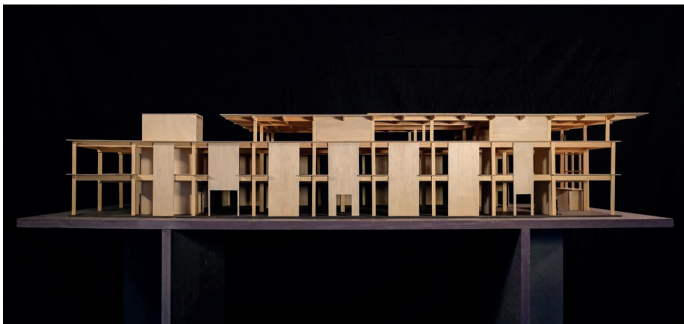
Nick Krouwel maakte een precieze maquette. In de langsgewel zijn platen CLT verwerkt voor de stabiliteit.
