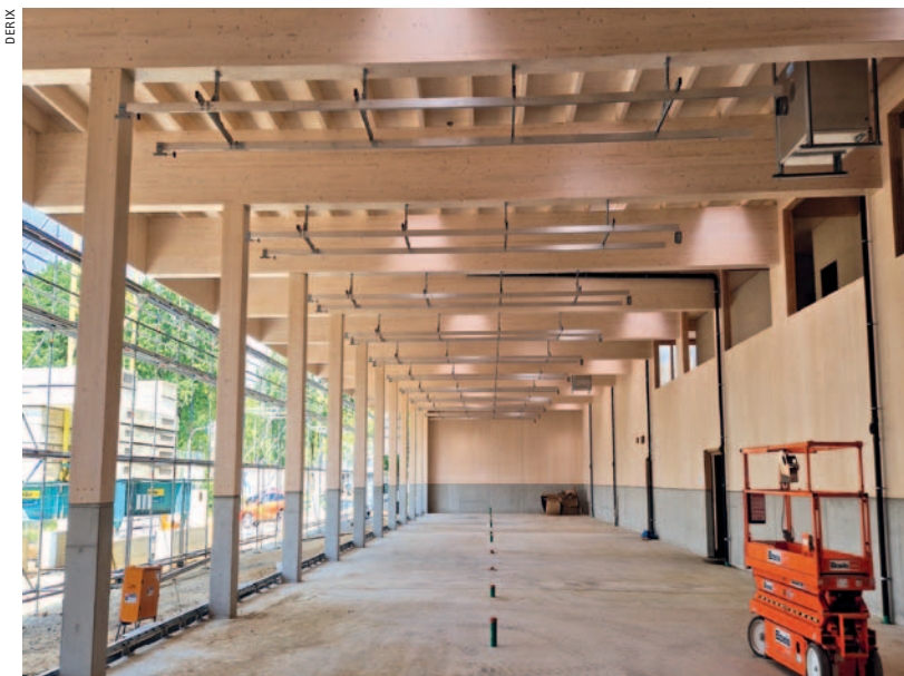
◀ 13 Binder, jeder über einen Meter hoch, überspannen 14 Meter und wiegen dabei selbst über vier Tonnen
