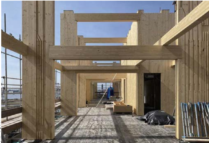
Zweigeschossige Loftwohnung während der Montagearbeiten. Die Unterzüge liegen in Ausklinkungen der BSP-Wandelemente.
