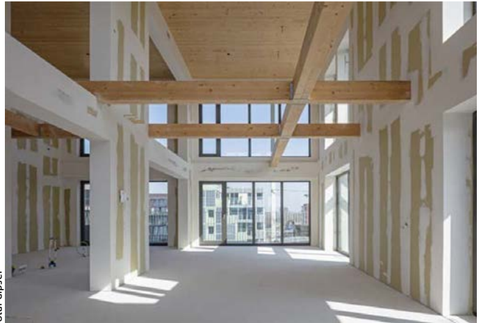
Aus Brandschutzgründen mussten die BSP-Elemente in den Loftwohnungen mit drei Lagen Gipsfaserplatten gekapselt werden.
