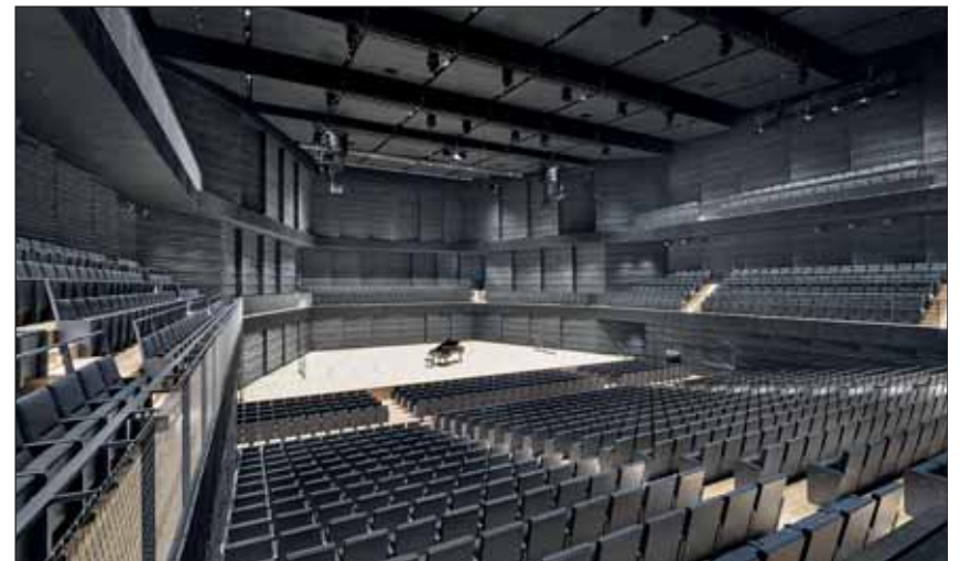
Blick in das als Isarphilharmonie bezeichnete Interimsgebäude Gasteig HP8 nach Fertigstellung. Die schwarz eingefärbten Brettsperrholz-Elemente an Wänden und Decke liefern laut Spezialisten eine außergewöhnlich gute Akustik.
