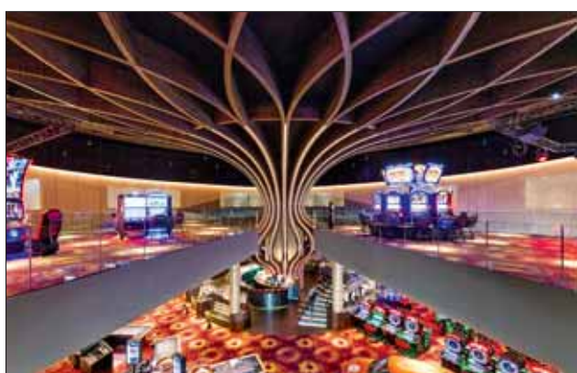
Die freigeformte Tragstruktur des Casinos in Venlo ist aus einfach und doppelt gekrümmten Brettchichtholz-Bogenbindern erstellt, die abgerundeten Wände in Holzelementbauweise. Foto: Barwerd van der Plas
