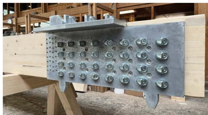
Ein speziell gefertigtes Stahlteil überträgt die Lasten der Fassadenelemente auf den Obergrut des darunterliegenden Elements.
