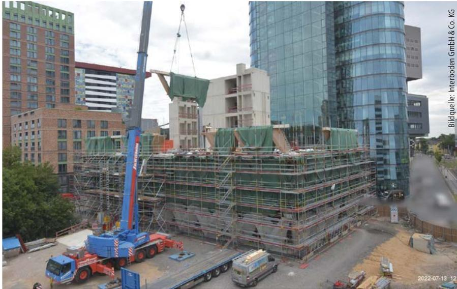
Die bis zu sechs Tonnen schweren und mit einem Maximalmaß von 17,20 m x 1,09 m x 3,49 m aufwartenden Fachwerk-Fassadelemente wurden als Ganzes vom Kran in die Stockwerke eingehoben.
