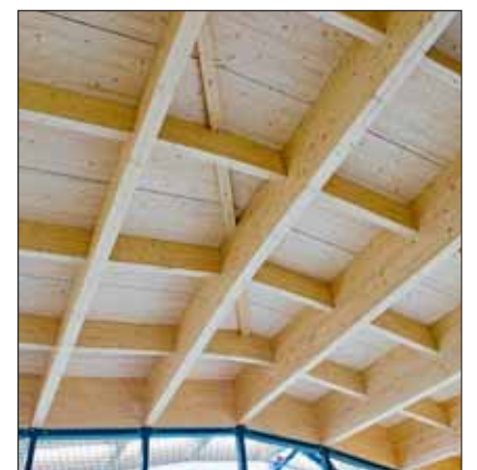
Die gitterförmige Struktur des Dachtragwerks besteht ebenso wie die obenauf montierte Dachscheibe aus Brettschichtholzelementen, die an den Stößen mit OSB-Streifen untereinander verbunden sind.
