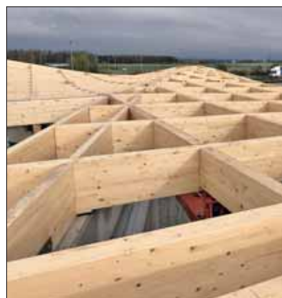
Die gitterförmige Struktur des Dachtragwerks besteht ebenso wie die obenauf montierte Dachscheibe aus Brettschichtholzelementen, die an den Stößen mit OSB-Streifen untereinander verbunden sind.
