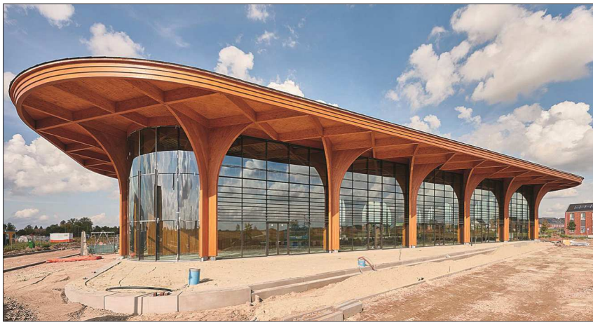
Das niederländische Architekturbüro De Zwarte Hond stellte das Projekt „Super-Hub“ vor, das als Mittelpunkt eines neu entstehenden Stadtteils fungieren wird. Bei diesem Holzbau, der kürzlich in Groningen (Niederlande) fertiggestellt wurde, standen bei den Planern sowohl die Zirkularität der Bauteile als auch möglichst flexible Nutzungsmöglichkeiten im Vordergrund. Foto: De Zwarte Hond
