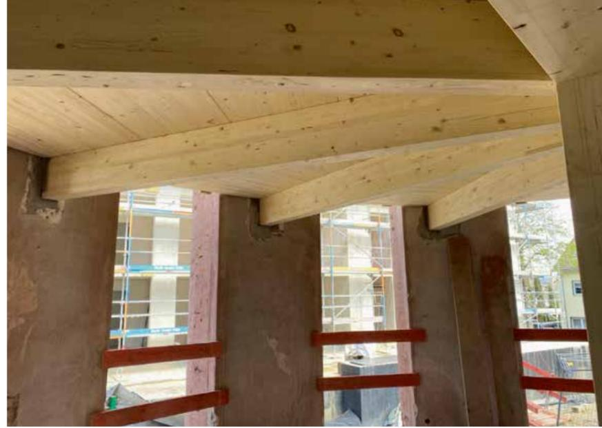
▶ Zwischen die historischen Außenwände und tragenden Bestandsinnenwände und Stützen in Massivbauweise platzierten die Zimmerer die Wand- und Boden-/Deckenelemente
