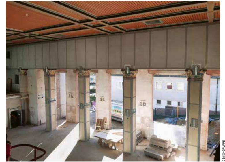
Zwischen die Wände bzw. den Stützen und den verschiedenen Haltesystemen platzierte man zwecks Reduktion von Wärmebrücken sowie als Korrosionsschutz der Stahlteile thermisch wirksame Trennelemente aus hartem PVC mit geschlossenzelligem Schaum.
