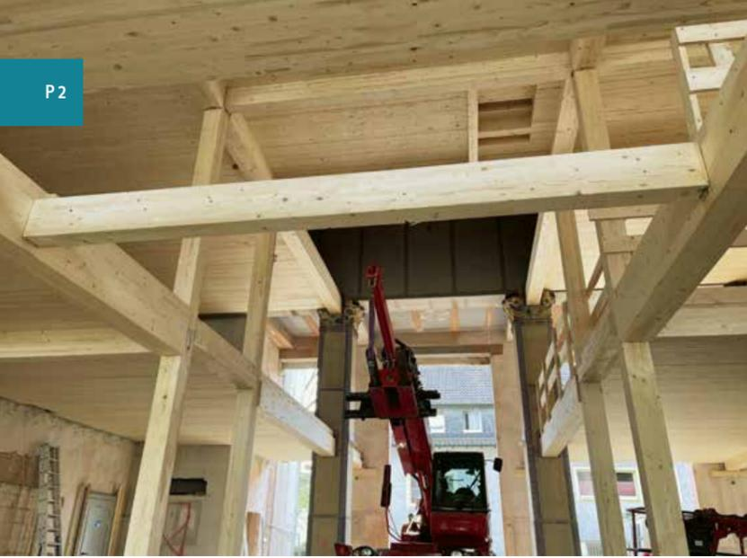
◀ BSH-Tragwerk mit BSP-Decken
