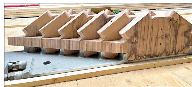
Der eigens für „The Cradle“ entwickelte Verbinder besteht aus einer Kragge aus Buchen-FSH, die auf eine Stahlplatte gesteckt ist. Es ist eine reine Steckverbindung, weder hier noch bei der Verbindung zwischen Kragge und Fassadenbauteil kommen Kleber oder Schrauben zum Einsatz.
