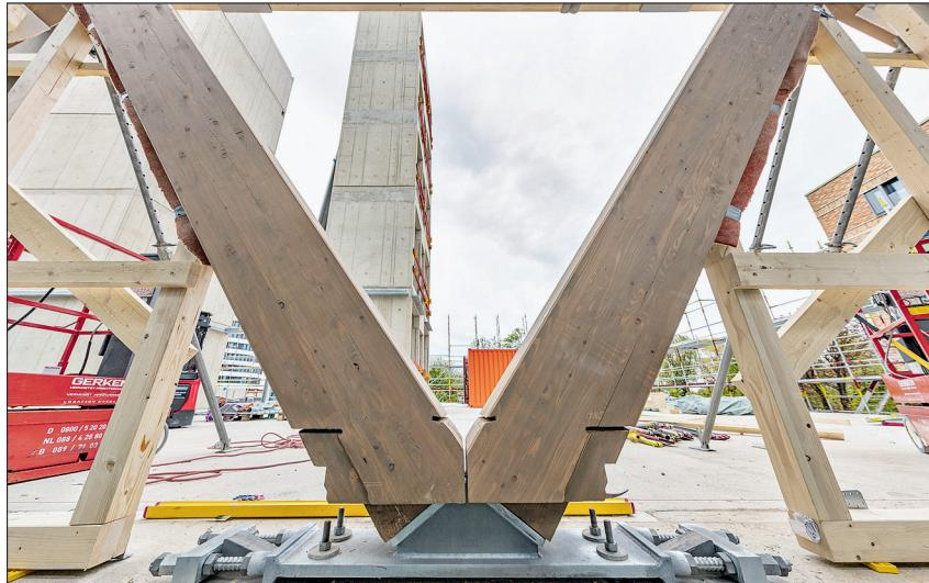
Anschluss eines Fachwerk-Fassadenträgers an den Steckverbinder
