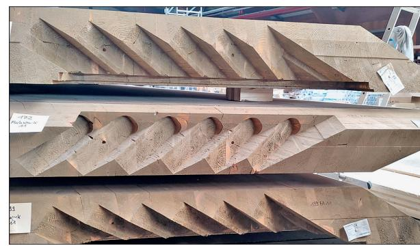
Ausfrässungen für die Steckverbindung an Fassadenbauteilen
