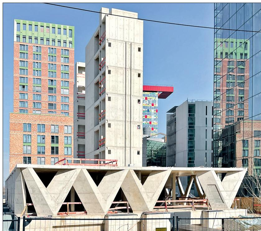
Start für die Montage des ersten Obergeschosses nach Errichtung des Erdgeschosses und der Erschließungstürme in Stahlbetonbauweise
