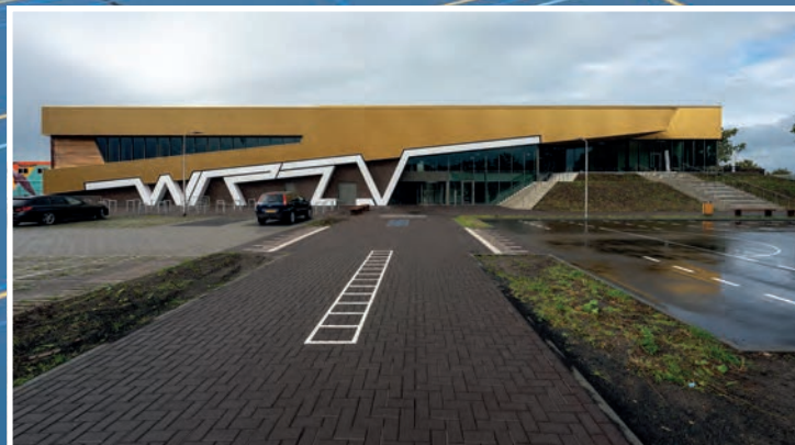
De naam van de Zwolse voetbalclub komt terug in de gevel. Links in de gevel thermisch verduurzaamd essen.
