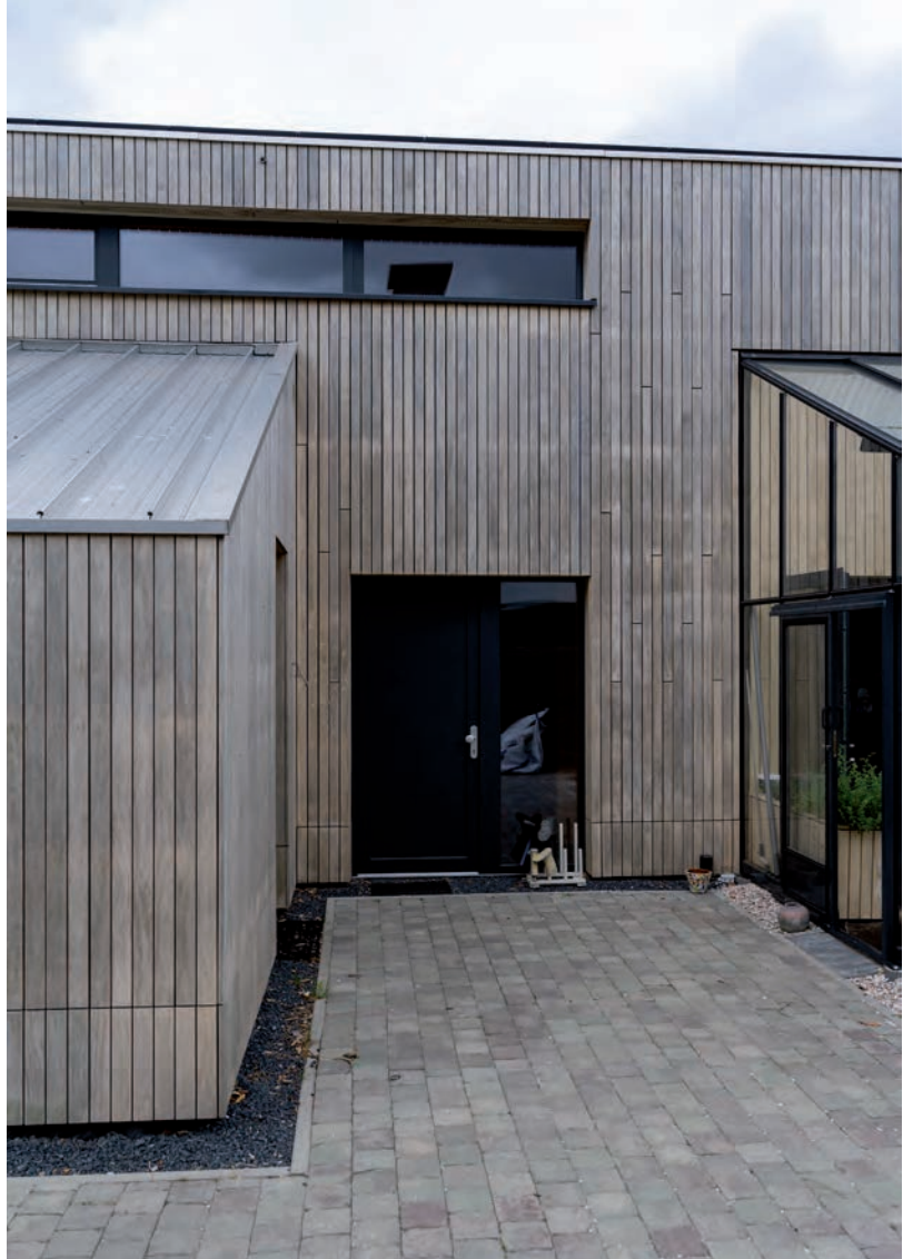
De voordeur bevindt zich tussen de fietsenbergingen een glazen kas, die vanuit de woning en van buitenaf bereikbaar is.
