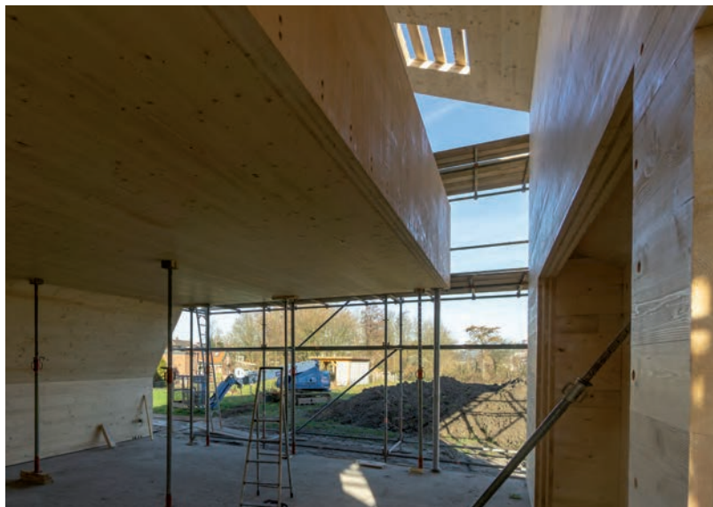
De enige stalen kolom in het hele huis ondersteunt aan het uiteinde de galerij.
