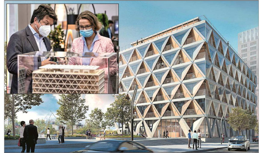
Die nordrhein-westfälische Bauministerin Ina Scharrenbach lässt sich von Markus Derix die Holzkonstruktion von »The Cradle« erklären. Das Projekt ist derzeit im Bau, in wenigen Wochen beginnen die Holzbauarbeiten.
