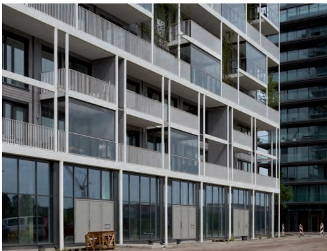
De eerste drie verdiepingen zijn van beton. Daarboven is het houtbouw, op een betonnen trappenhuis na, dat voor stijfheid van de constructie zorgt.
