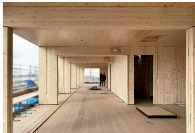
Om aan het Open Building-principe te voldoen zijn de ruimten zo veel mogelijk open gehouden, met de installaties aan de kant van de lift.
