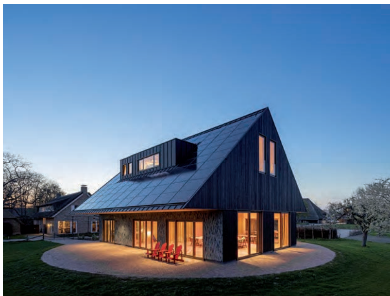
Geschikt voor lange, genoeglijke avonden. De grote dakkapel vormde een uitdaging voor de constructeurs.
