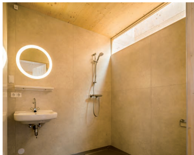
Badkamer met natuurlijk licht door de zonneshoortsteen. De natte groep is als een unit ingebouwd, al het leidingwerk zit achter de uitneembare tegels.
