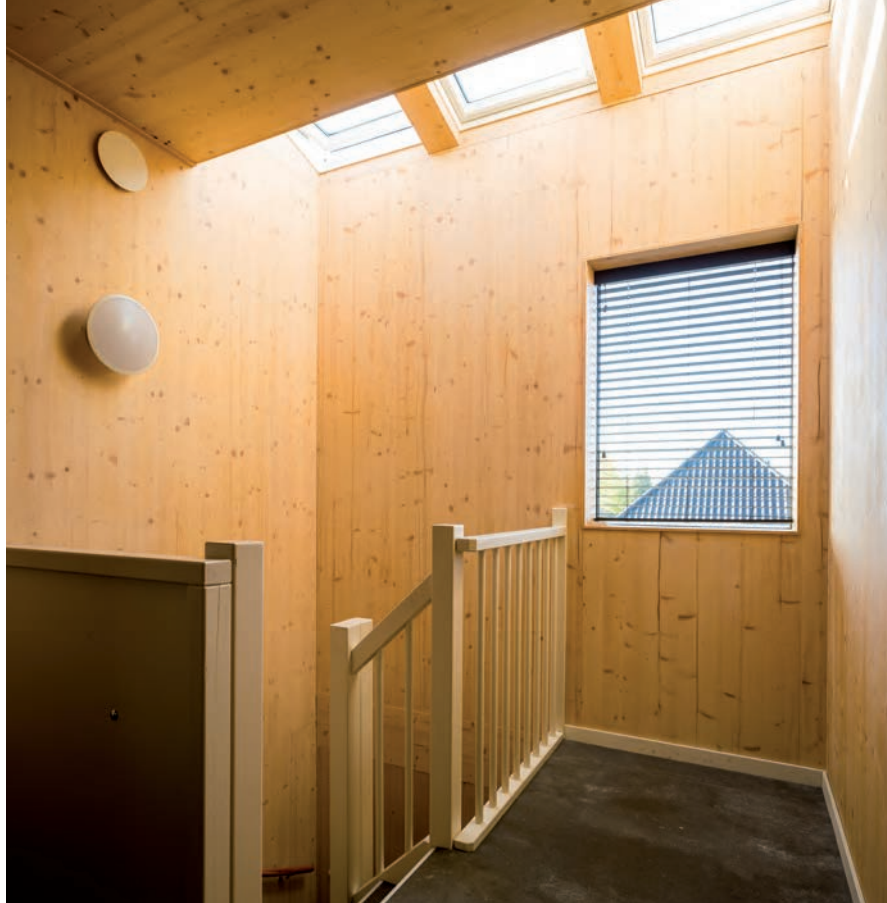
Zolderverdieping met links de 'technische wand' waar alle leidingen in samen komen. Daarom zit het ganglicht ook niet aan het plafond maar aan die wand.
