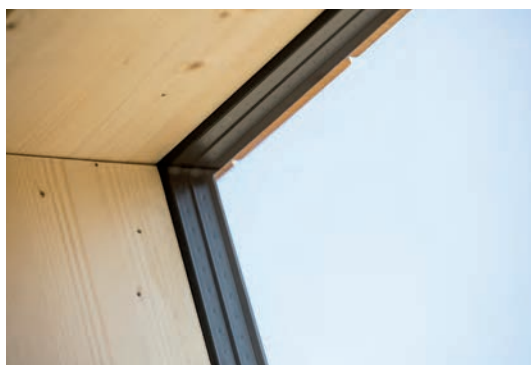
Kozijnloze ramen. Dat scheelt materiaal en is ook makkelijker te plaatsen en te verwijderen.
