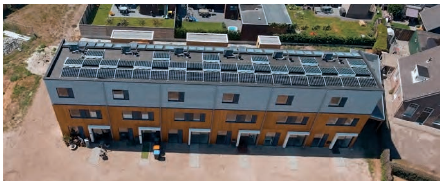
Op het dak liggen zonnepanelen en zijn de dakramen boven de zonneshoortstenen en de trappenhuizen.
