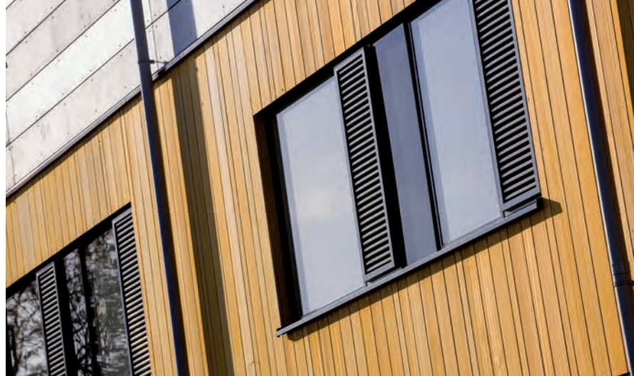
Uiteraard is de gevelbekleding van (verduurzaamd) hout. De grijze beplating bovenaan is het enige cementhoudende van het hele huis. Bouw • Novum denkt voor volgende projecten aan bamboe.
