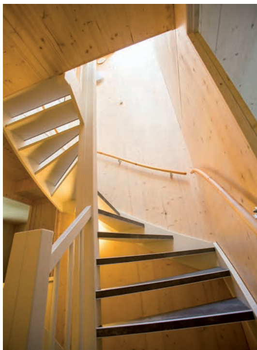
Boven het trapgat bevindt zich ook een dakraam, de woning wordt dus op twee plaatsen van bovenaf van daglicht voorzien.
