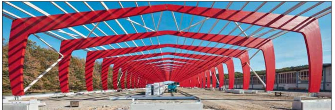
Fast 50 m überspannen die Dreigelenkrahmen aus Brettschichtholz, welche die tragende Konstruktion der neuen Fertigungshalle in Westerkappeln bilden. Die BSH-Träger wurden bei Derix selbst produziert. Foto: Derix-Gruppe
