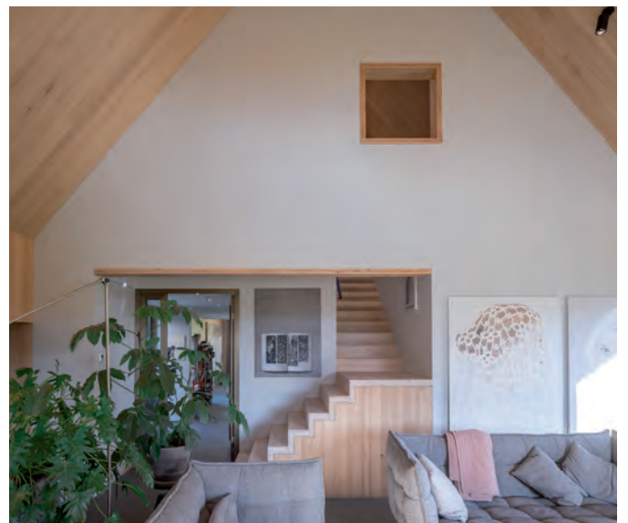
De eerste verdieping kijkt aan twee kanten uit op de begane grond. Ook de trap is van kruislaaghout gemaakt, met een laminaatlaagje tegen slijt door schoenen
