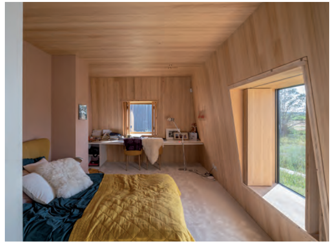
De zichtzijde van het kruislaaghout is van zilverspar. Ook de luiken zijn van (smal) kruislaaghout en kunstig in de brede vensterbanken verwerkt.
