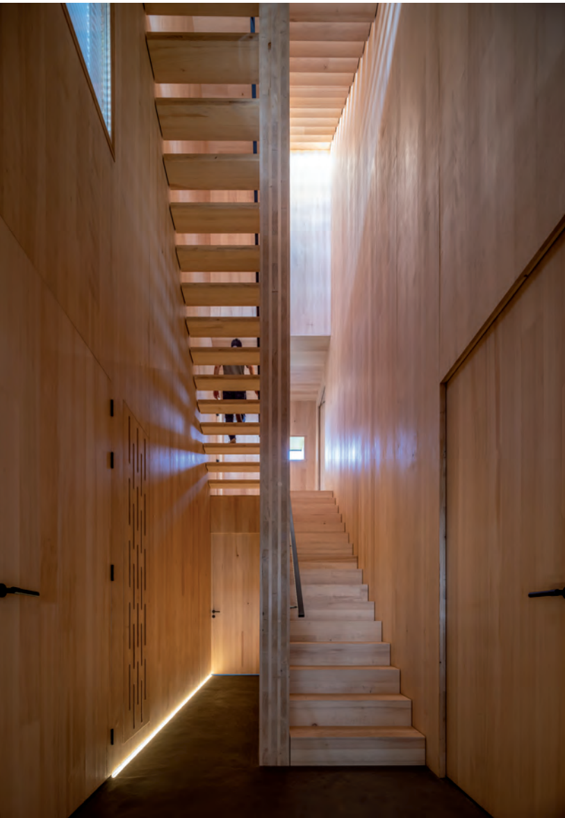
Het trappenhuis van kruislaaghout is een belangrijk dragend element van de 'toren'
