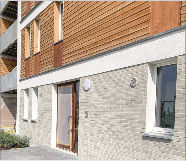
Detail der Fassade im Projekt Vogelkamp: Erdgeschoss als Massivbau in Mauerwerk erstellt und verklinkert, die darüber liegenden Geschosse als Holzmassivbau in Brettsperrholz ausgeführt. Zur Isolation wurden Holzrahmenelemente mit Dämmung und einer Außenhaut aus unbehandelter Lärche verbaut.
