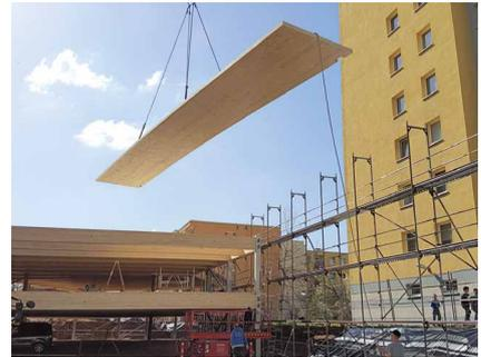
Abb. 18: Rohbau Montage BSP-Deckenelement (© Derix-Gruppe)
