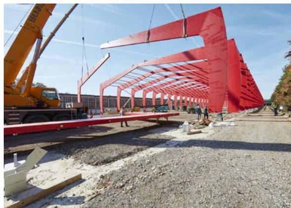
Die Spannweite der zusammengesetzten Rahmen beträgt über 45 Meter
