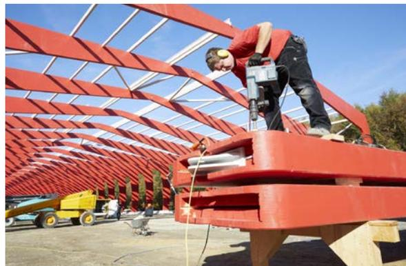
Eine Konstruktion aus Brettschichtholz-Dreigelenrahmen bildet das Tragwerk der neuen Halle
