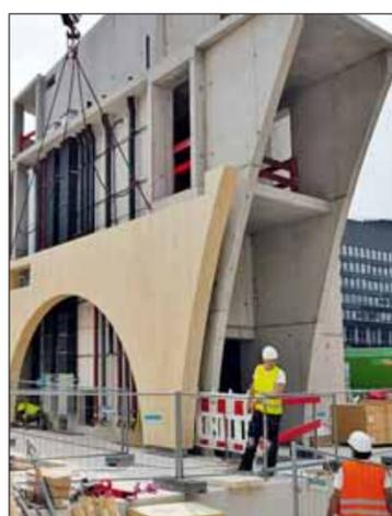
Der Stahlbeton-Erschließungskern steift die Konstruktion aus.
