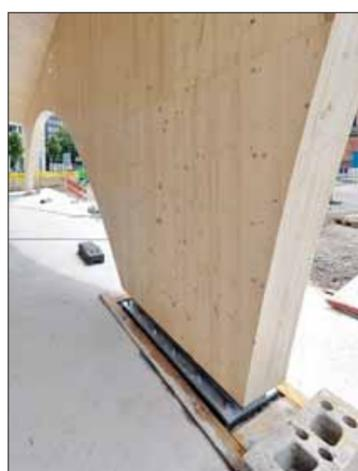
Die Anschlüsse und Verbindungen der BSP-Elemente erfolgte mit Stahlschuhen und Stabstahl H-Profilen.
