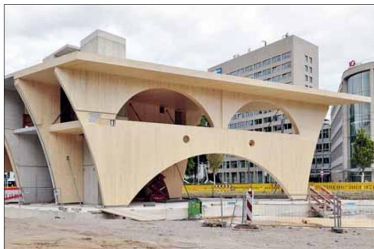
Die geometrischen Elemente aus Brettsperrholz wurden werkseitig in Gänze vorgefertigt und in kurzer Zeit montiert.
