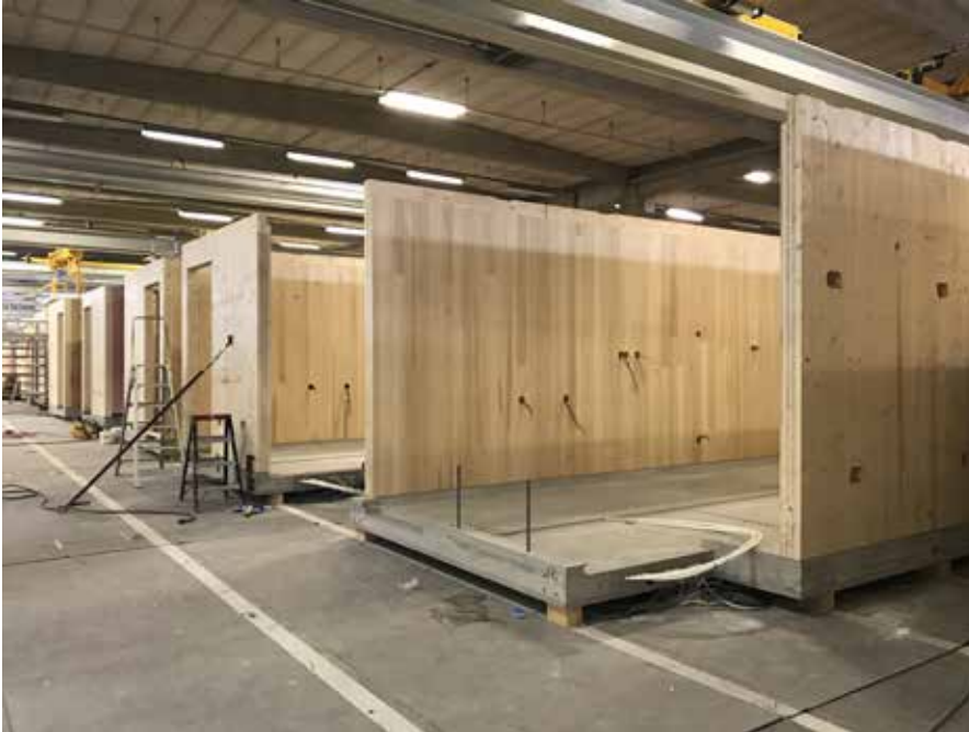
Bild 4: Vorfertigung im Werk: In die Aufkantung der Stahlbeton-Bodenplatte eingelassene Gewindestangen dienen als Anschlusseisen für die Wände (Bildquelle: Ursem Modulaire Bouwssysteme)
