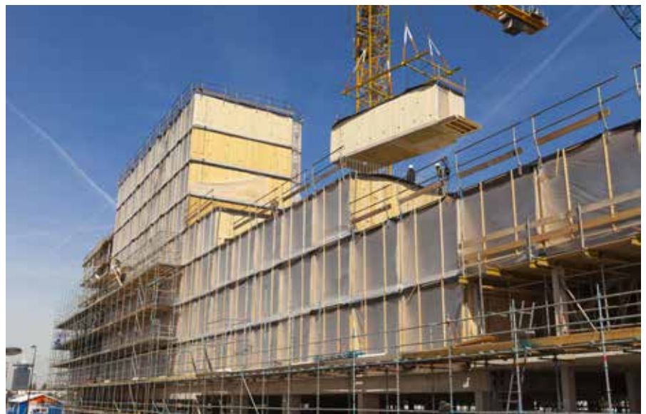
Bild 3: Montage der Raummodule. Pro Tag wurden bis zu zwölf Stück montiert. (Bildquelle: Derix-Gruppe)
