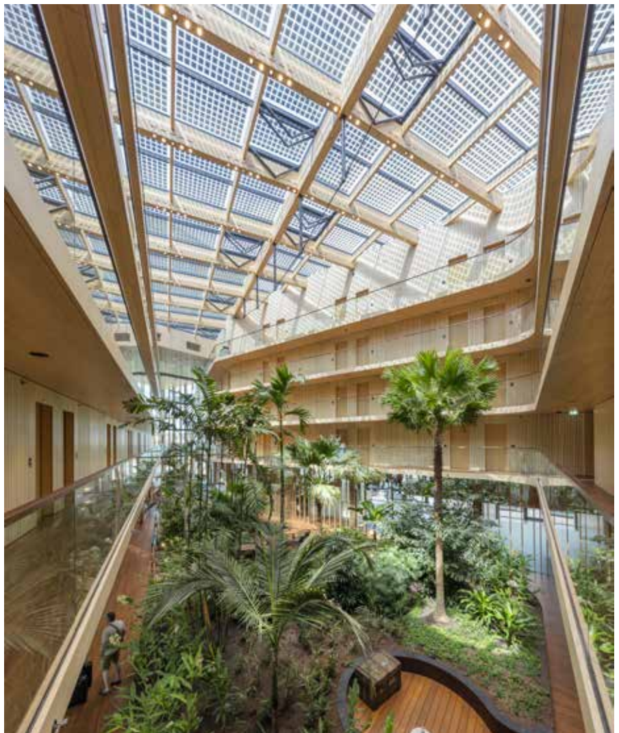
Bild 7: Die Zimmer werden über Laubgänge erschlossen, die zum zentralen Innenhof ausgerichtet sind. Diesen überspannt eine Holzkonstruktion mit Glasdach. (Bildquelle: Derix-Gruppe)
