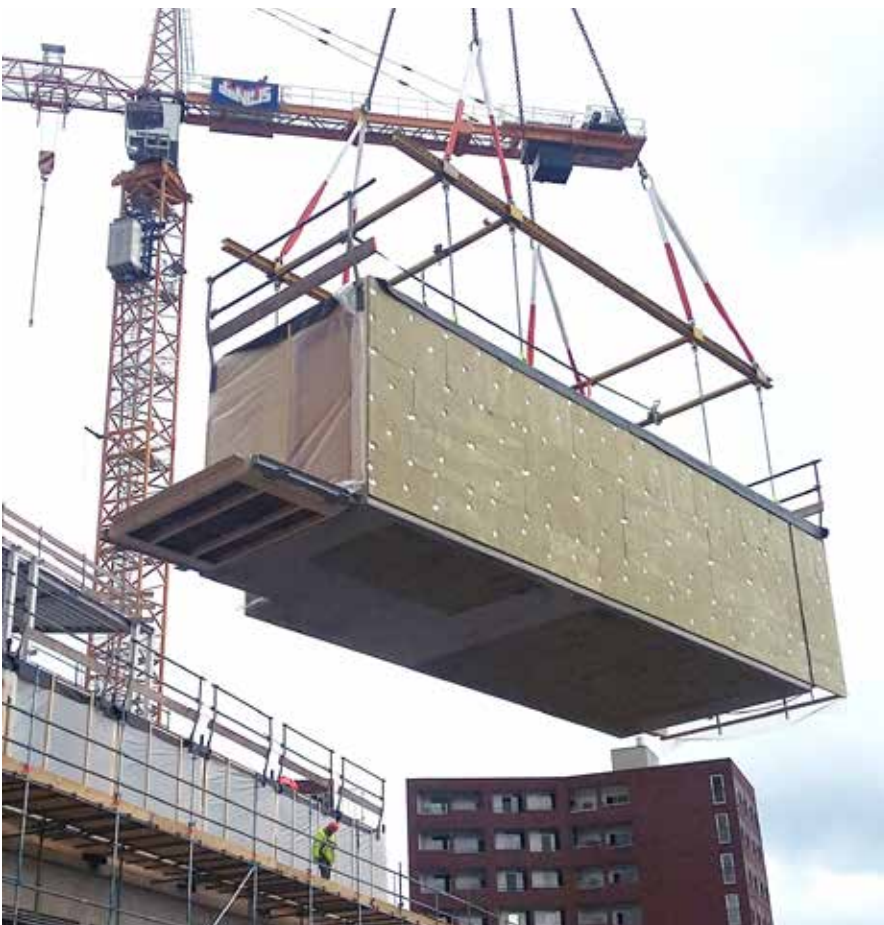
Bild 5: Raummodul mit überstehendem Gang-Element (rechts) für die Laubengänge rund ums Atrium. Die unterseitig aufgebrachte Dämmlage schließt bündig mit den Aufkantungen ab. (Bildquelle: Derox-Gruppe)
