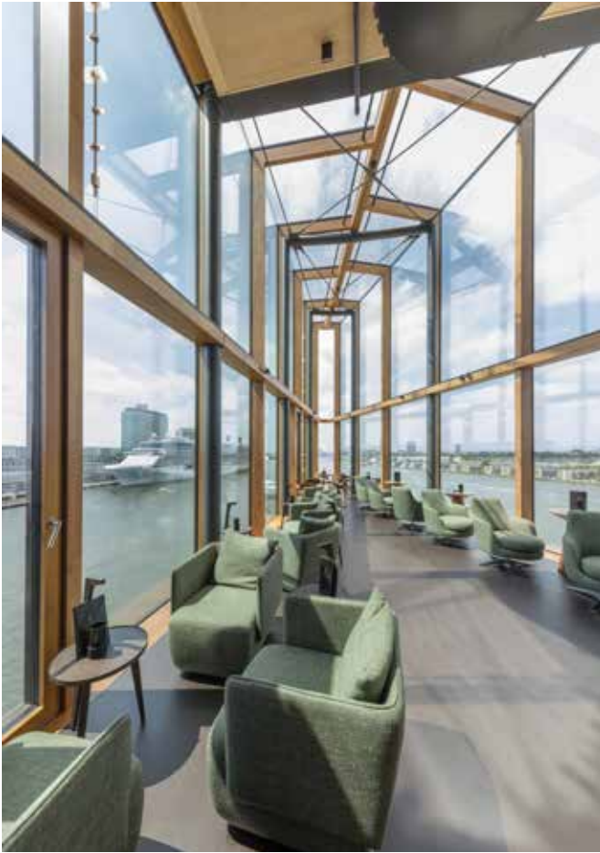
Bild 8: Das Dach der Skybar besteht aus dreischichtigem Glas. Fassade und Dach sind über eine sehr dezente Glas-auf-Glas-Verbindung miteinander verbunden, so dass die innere Pfosten-Riegel-Vorhangsfassade aus Brettschichtholz durchgängig sichtbar ist. (Bildquelle: Derix-Gruppe)
