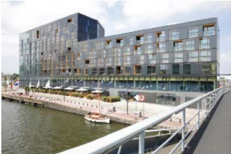
Die Wahl einer Bodenplatte aus Stahlbeton hatte nach der Aussage von Kathrin Hanf, der Projektleiterin bei SeARCH, mehrere Vorteile: „Nur durch die dünne Betonplatte war es möglich tatsächlich 200 an den Fassaden gelegene Zimmer auf dem relativ kleinen Grundstück bei idealer Belichtung unterzubringen. Eine Holzfußbodenkonstruktion hätte die Modulhöhe derartig beeinflusst, dass ein gesamtes Geschoss weniger gebaut worden wäre, um innerhalb der Grenzen des Bebauungsplans zu bleiben.“
