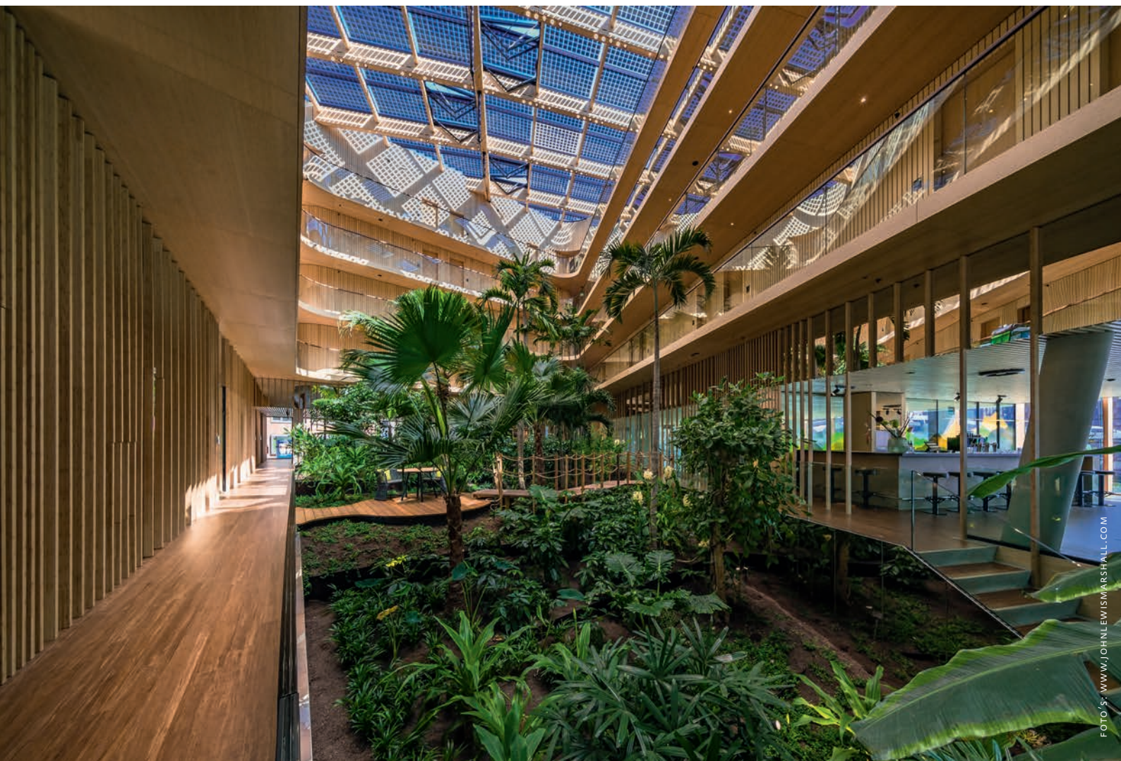
Atrium. De schitterende gelamineerd vuren constructie van het glazen dak is in één middag bedacht.
