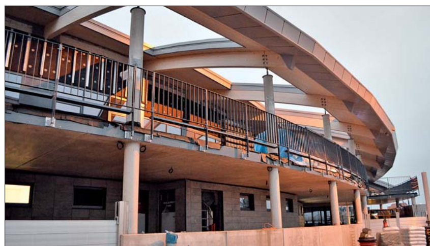
BSH-Dachtragwerk auf Stahlbeton-Rundstützen
