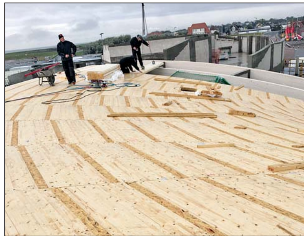
Die das Gebäude aussteifende Dachscheibe besteht aus massiven Brettstapelelementen.
