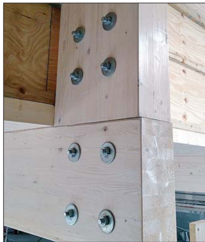
BSH-Detail: kraftschlüssiger Verbund mittels Vollgewindeschrauben
