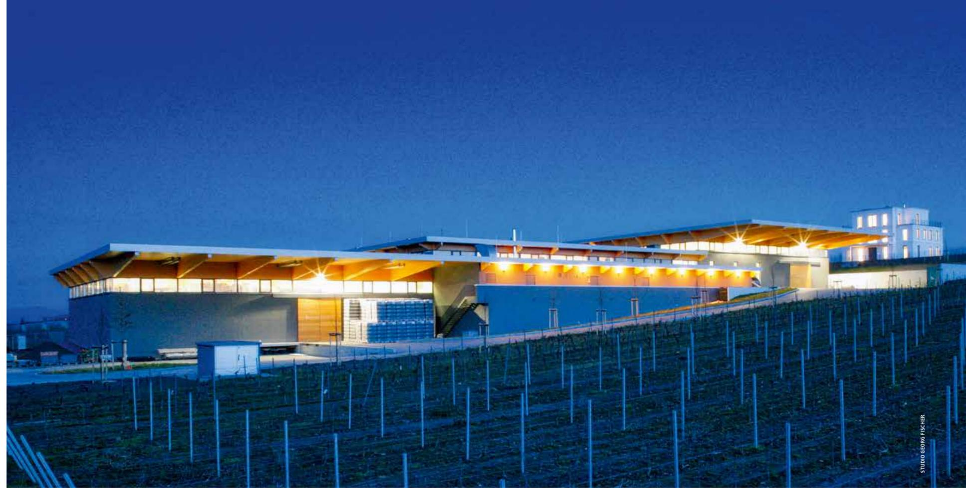
zur Verfügung. Das Gebäude wurde auf einem Streifenfundament gegründet. Die vom Tragwerk entkoppelte, 25 cm dicke Bodenplatte aus Stahlbeton verfügt über eine XPS-Perimeterdämmung gegen das Erdreich von 60 mm.
