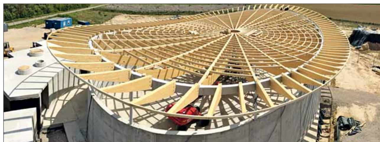
Die oval-geschwungene Form des Speichenrads wird von 32 Hängeträgern gebildet. Foto: Ing.-Holzbau Krogmann GmbH
