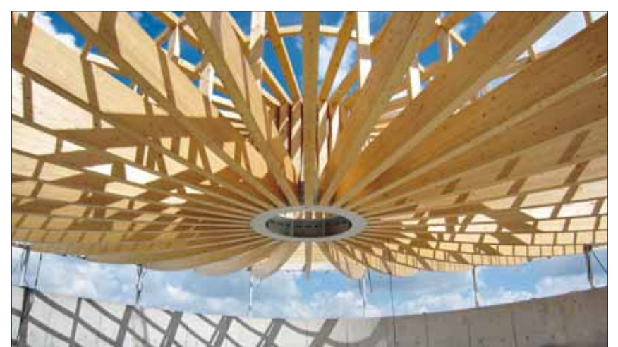
Die unikate, außergewöhnliche Speichenrad-Tragwerkstruktur lagert auf relativ schmalen Stahlstützen. Foto: Ing.-Holzbau Krogmann GmbH (3)
