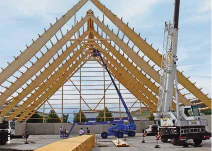
◀ Im First verbinden trägerbreite Doppel-T-Stahlteile die Fischbauch-Träger. Koppelpfetten überspannen die Binder
