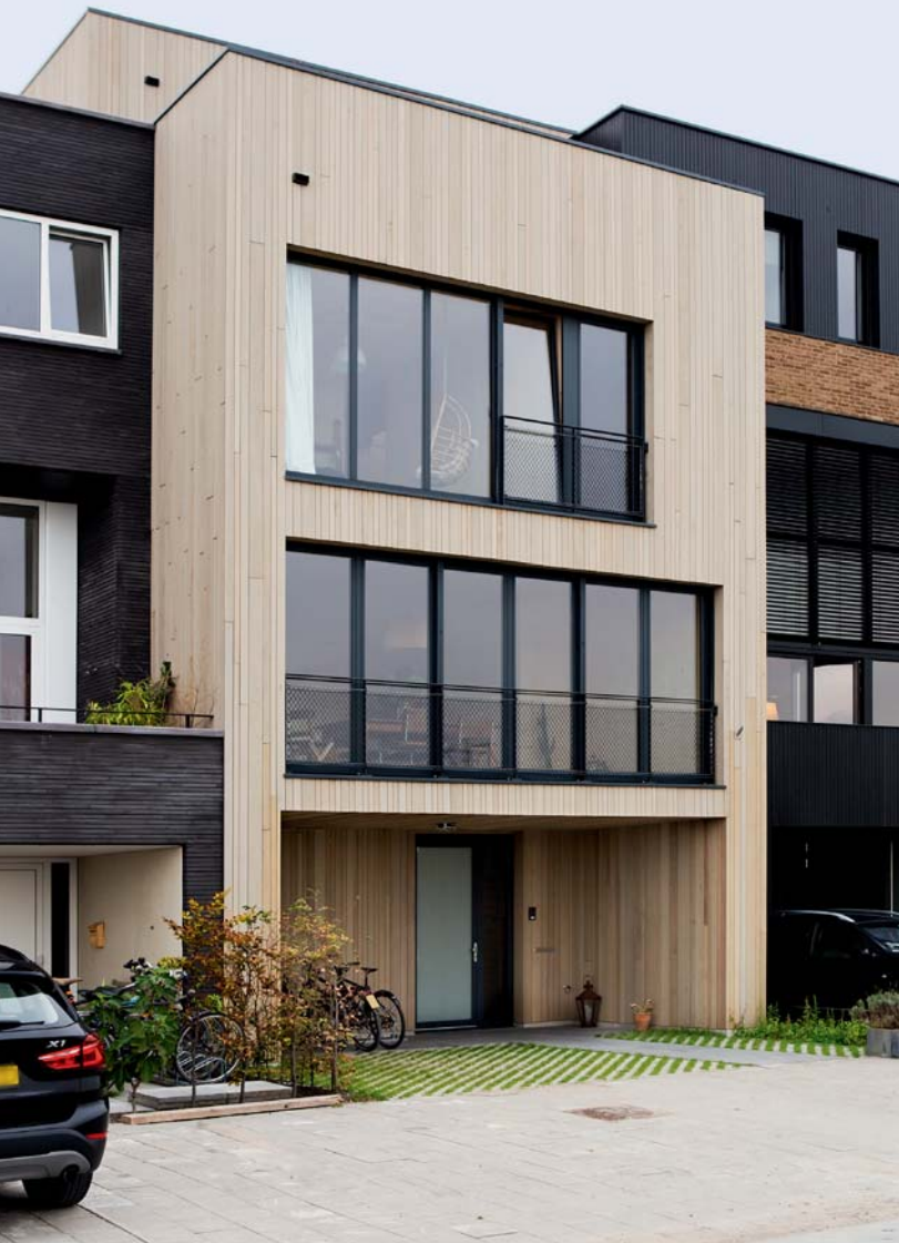
Buiten straalt al het gevelhout: verticaal western red cedar in drie breedtematen (60, 90, 150 mm).
