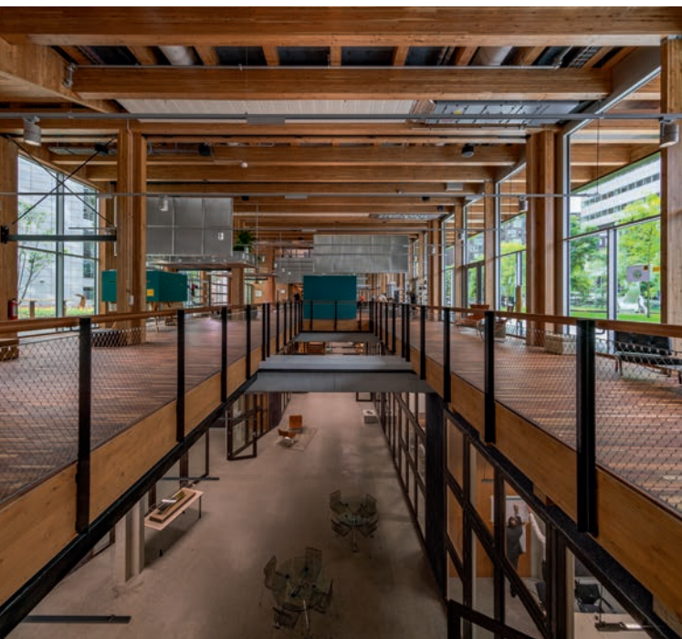
De verbinding tussen souterrain en begane grond boven is open, zodat onder veel licht naar binnen valt.
