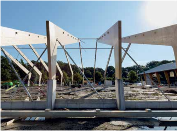
▲ Der keilgezinkte Rahmen noch ohne Druckriegel im Montagezustand
