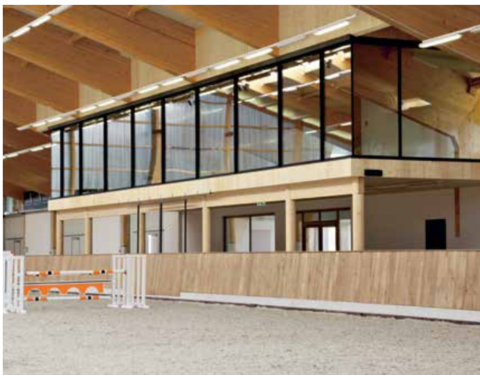
▲ Die verglaste Loge thront über dem Eingangsbereich der großen Reithalle. Hier finden große Turniere statt
