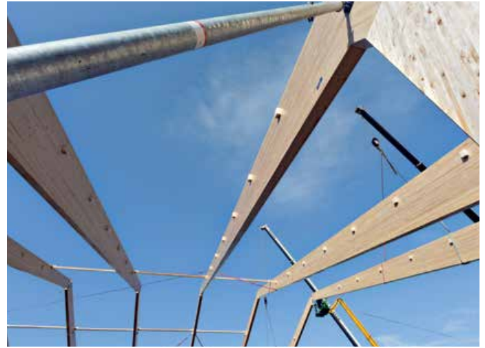
▲ Abgestrebte Verbandsdiagonalen über Montagestützen und Kettenzügen
