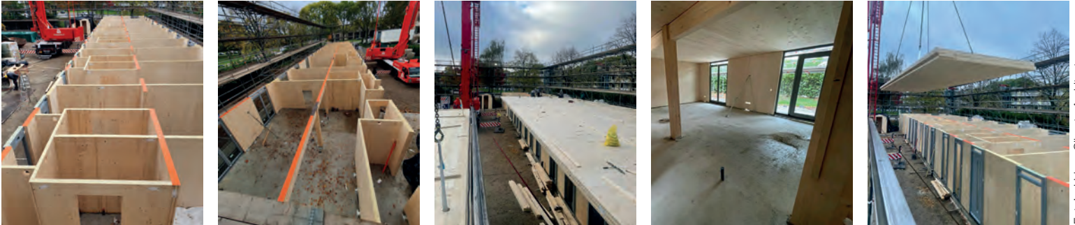
De realisatie van Grote Kreek in Rotterdam. Vijftig zorgunits voor het Leger des Heils. Het hele gebouw wordt opgetrokken in CLT.
