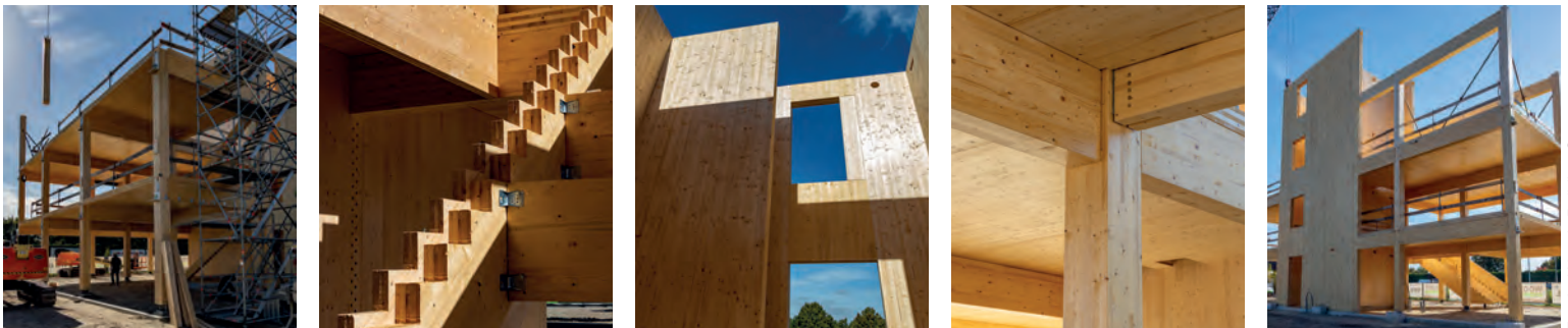
De bouw van het Houtlab van Woody Building Concepts, in Nieuwkuijk. De bedrijfshal - 1150 m 2 inclusief kraanbaan - is helemaal uitgevoerd in gelamineerde kolommen en liggers, het kantoor - 1200 m 2 - is uitgevoerd in gelamineerde kolommen en CLT.
