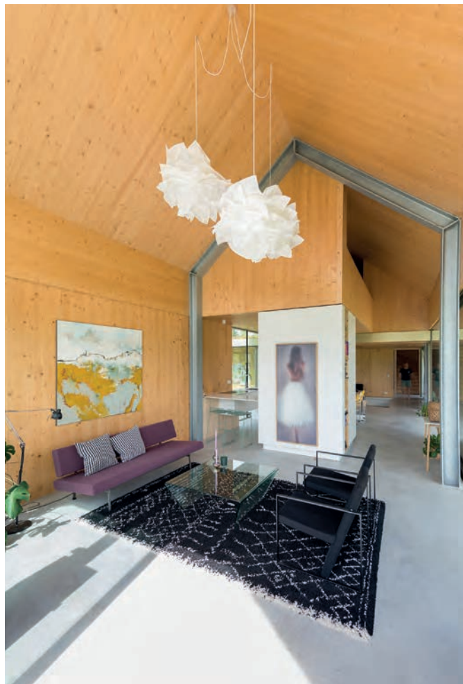
Enkele stalen spanten ondersteunen het CLT, dat ook zelf in de constructie meewerkt.
