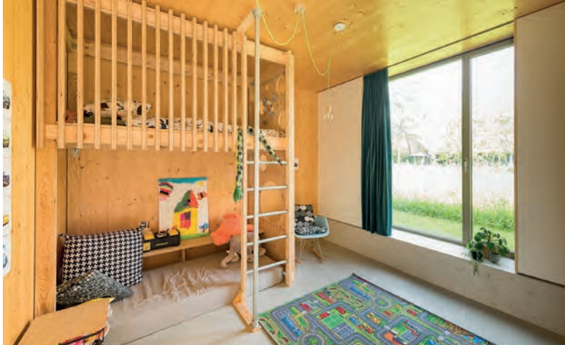
Eén van de kinderkamers. Behalve in de badkamers is in het hele huis het constructieve CLT in het zicht gehouden.
