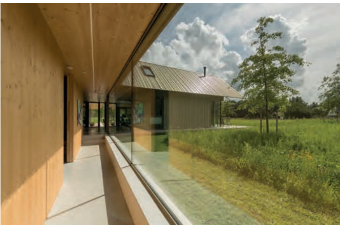
Links liggen de slaapvertrekken van het gezin, de wand van de gang is geheel van glas. Het dak van CLT steunt op wanden van CLT.
