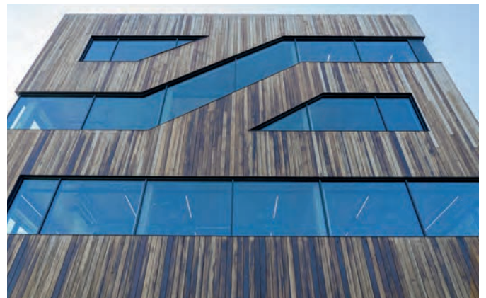
De aluminium vliesgevel is ten opzichte van de frakégevel iets teruggelegd zodat de houten banden beter tot hun recht komen.
