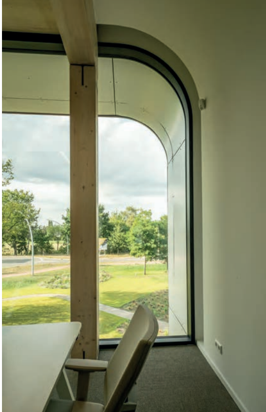
Aansluiting ronde kopgevel op houten CLT constructie.
