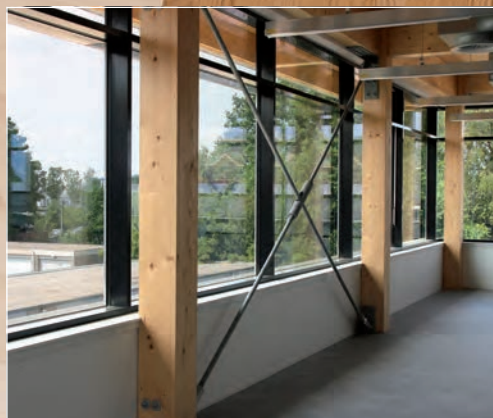
Stalen kabels zijn verankerd met zware stalen kop- en voetstukken in het hout.
