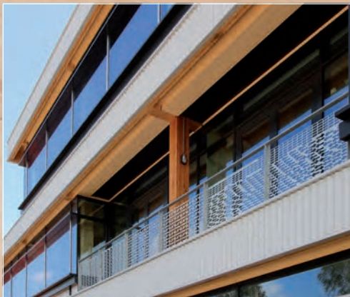
De kolommen zijn van lariks, de liggers van vuren. Tussen de liggers 'hangen' hsb-wanden.
