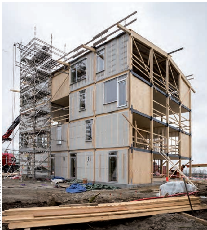
Duidelijk is hier de opbouw te zien met de smalle kolommen en liggers, de dakconstructie en de hsb wandelementen.
