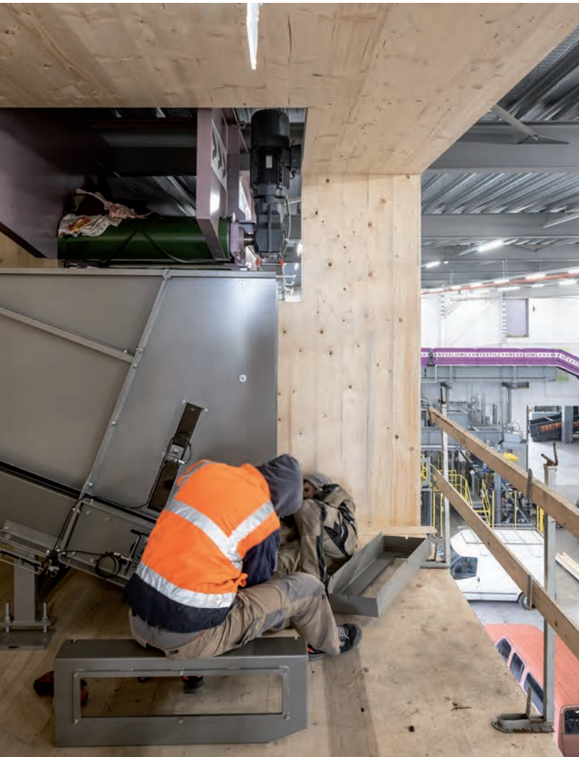
Werkzaamheden aan de transportband in het eindgedeelte van de tunnel, waar die 8 meter breed is. Hier komen tal van bedrijfsfuncties bij elkaar.
