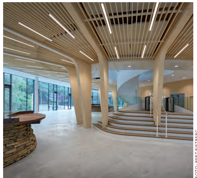
Drie kernen van kruislaaghout zijn de dragers van het gebouw, hierin zijn ook de liftschachten geschroefd. Gebogen gelamineerde kolommen dragen de kruislaaghouten verdiepingvloeren.
