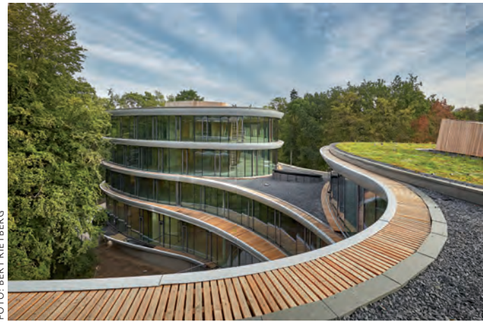
De dragende constructie van het nieuwe kantoor van de Triodos Bank in Driebergen bestaat uit hout. De gevels zijn rijkelijk voorzien van glas en stalen contouren.
