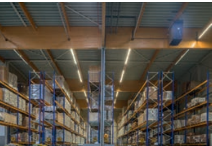
Magazijn met imponerende dakconstructie van gelamineerd vuren langsliggers en dwarsdragers boven de bijna gebouwhoge stellingen.
