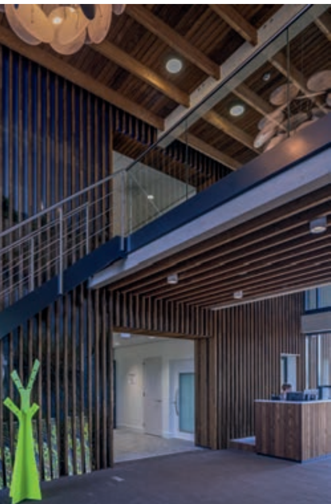
De houten uitstraling is optimaal in het entreegebied waar een overvloed van lariks balken op wanden en plafonds gerijd feestvieren.
