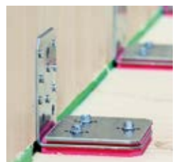
Uitgespaarde stootverbinding, loodrechte zelfborende schroeven
