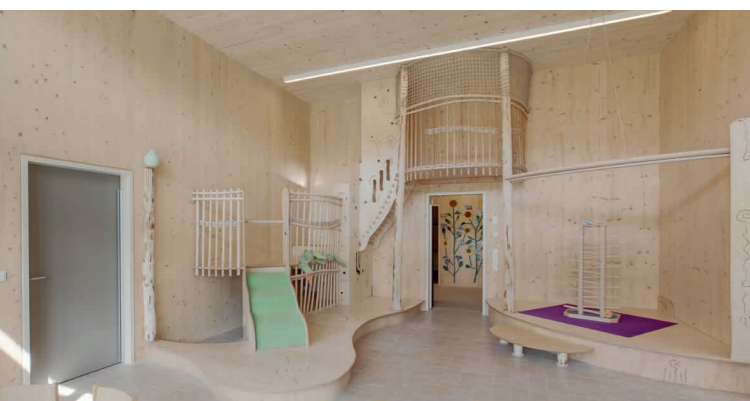
Wände und Decken aus X-LAM Kita Bösinghoven
