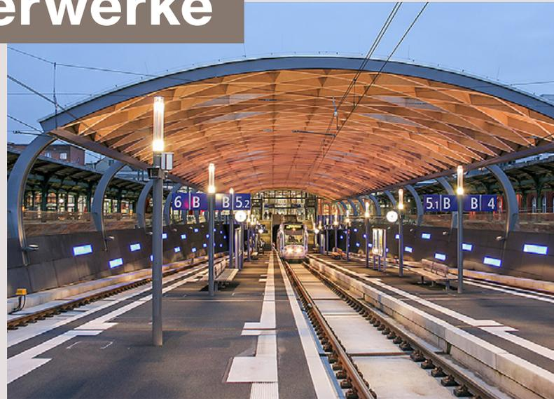
**Holz ist ein vergleichsweise leichtes Baumaterial. Nutzt man es zur Konstruktion von Gitterwerken, erhält man ebenso leichte wie hochbelastbare Tragwerke, meist für weitgespannte Dachkonstruktionen.**
