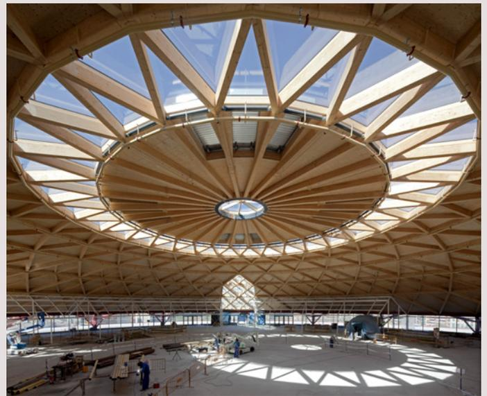
Eine weitere Schlüsselstelle bei der Konstruktion eines Zollingerdaches liegt darin, die optimale Stabgeometrie zu finden, die eine hohe Passgenauigkeit zulässt. Denn sie bestimmt das Gelingen und die Wirtschaftlichkeit dieser Konstruktion. Dadurch dass jedoch alle Stäbe des Dachtragwerkes den gleichen Zuschnitt erhalten – Sonderstäbe gibt es nur bei den Randanschlüssen – kann der maschinelle Abbund meist mit relativ geringem Programmieraufwand erfolgen.
