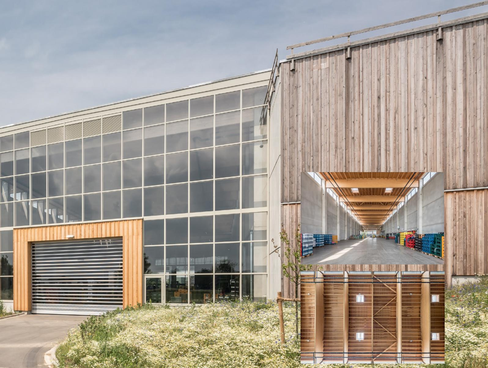
und überhöhte Zangenunterzüge ein, die die Dachlasten aufnehmen und in die Stahlbeton-Stützen ableiten.
